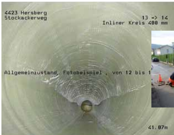
Beispiel Inlinersanierung
